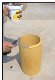
Pripremljen lepak nanosimo na unutrašnje ivice šamotne cevi.
