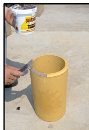
Dobro pripremljen lepak nanosimo na unutrašnje ivice šamotne cevi.
