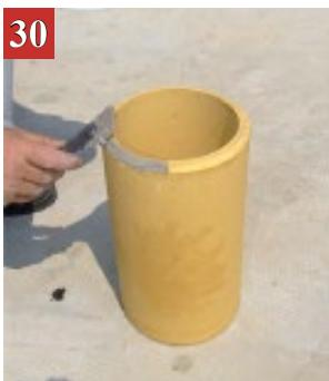
Obe strane isečene šamotne cevi očistimo od prašine, nanesemo vatrostalni lepak i postavimo u dimnjak.
