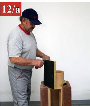
Ako gradimo dimnjak sa izolacijom između plašta i priključka za čišćenje postavimo izolaciju od kamene vune tako da rebrasta strana bude prema šamotnim cevima.
