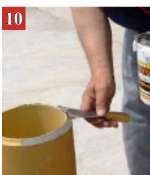
Pripremljen vatrostalni lepak nanosimo na stranu sa unutrašnjim falcom priključka za čišćenje.
