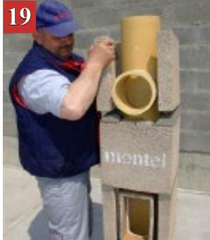
Postavimo plašt na svoje mesto i postavimo distancere ili izolaciju od kamene vune između plašta i priključka za kotao.
