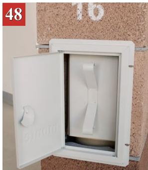
U otvor priključka za čišćenje stavimo unutrašnji uložak i zatvorimo vrata.
