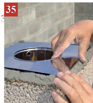
Dilatacionu rozetu postavimo na malterom pokriven plašt, nakon toga i na nju nanosimo sloj maltera.
