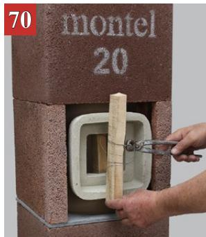
Zalepimo ugradni deo priključka na šamotnu cev i španujemo žicom. Kada lepak očvrse (oko 24 sati), otklonimo španer i postavimo prednju izolacionu ploču.
