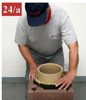
Ako želimo izolovan dimnjak između plašteva i šamotnih cevi umesto distanca po stavimo izolaciju od kamene vune.
