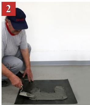
Na izolacionu ploču razastrimo produženi cementni malter za zidanje, pripremljen u odnosu 1:2:8
