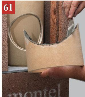
Površine koje se lepe očistimo od prašine, a na ivice ugradnog dela priključka nanosimo vatrastalni lepak.
