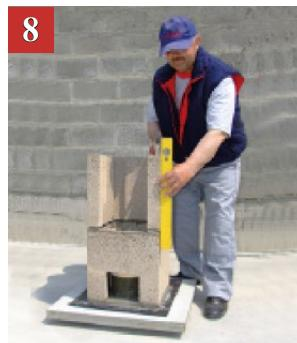
Na gornju površinu prvog plašta nanosimo produženi cementni malter i postavimo plašt sa otvorom za vrata.
