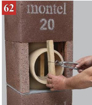
Zalepimo ugradni deo priključka na šamotnu cev i španujemo žicom.
