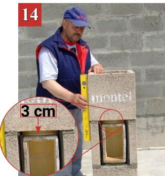
Na plašt od priključka za čišćenje nanosimo produženi cementni malter i postavimo sledeći plašt. Plašt treba iseći i namestiti da ostane razmak min. 3 cm između plašta i okvira za čišćenje.
