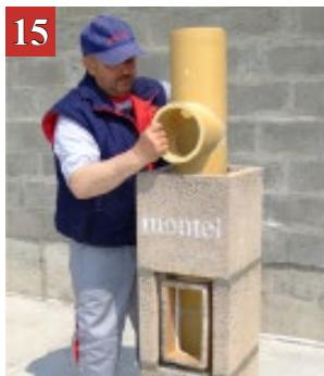
Obe strane priključka za kotao očistimo od prašine, na stranu sa unutrašnjim falcom nanosimo vatrostalni lepak i postavimo na priključak za čišćenje tako da strana sa lepkom bude okrenuta prema dole.
