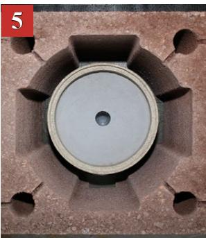
U plašt postavimo posudu za odvod kondenz vode.
