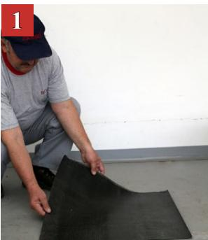
Unapred pripremljeni temelj treba podići na visinu poda, preko toga postavimo hidroizolaciju.
