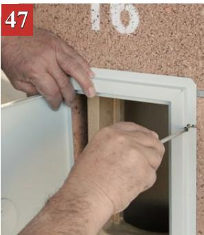
Pre malterisanja dimnjaka, na plašt zašara-fimo ram vrata za čišćenje.
