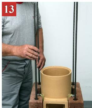
Ako je zbog visine dimnjaka potrebno ojačanje u postojeće otvore na plaštevima stavimo a r m a t u r u (m i n. Ø10mm) i zalijemo malterom.
