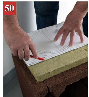
Pomoću šablonu precrtamo dimenzije prednje izolacione ploče od kamene vune i nožem isečemo je na meru.
