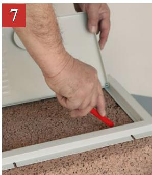
Na sledećem plaštu obeležimo unutrašnju dimenziju rama vrata za čišćenje i isečemo otvor fleksom.
