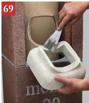
Površine koje se lepe očistimo od prašine, a na ivice ugradnog dela priključka nanosimo vatrostalni lepak.
